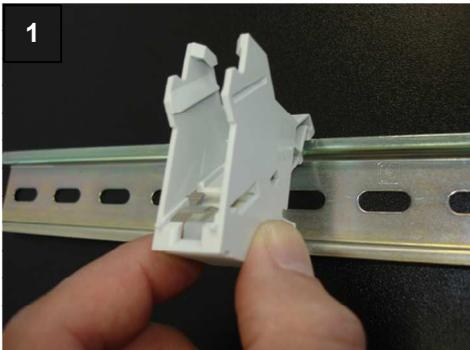
Das Gehäuseunterteil des DIN-Schienen E-2000™ Moduls auf die Montageschiene einrasten.
